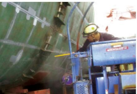
船体外板やタンクの溶接部は内部の欠陥まで調べるためにX線透過検査を行います。
