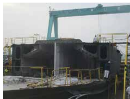
建造中の貨物タンク。三角がトップサイドタンク
